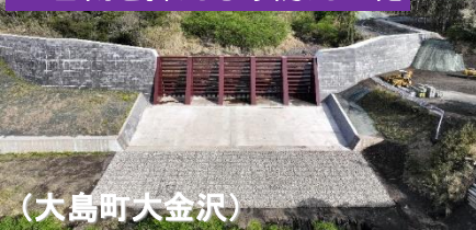
土石流を抑える砂防えん堤
