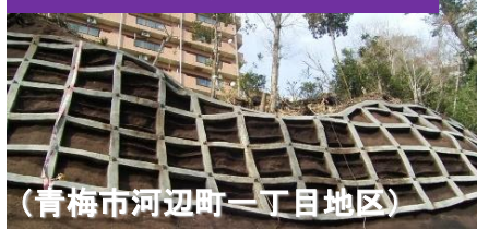
急な斜面を保全する法枠工
