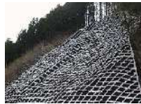
法枠による斜面対策
