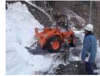
地元業者による除雪作業
