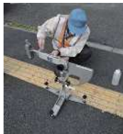
路面すべり抵抗調査
