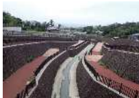
大金沢流路工
