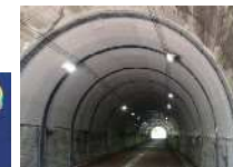
トンネルの補修・補強
