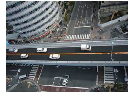
新小岩陸橋（たつみ橋交差点上空から）
