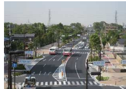
調布保谷線（神代植物公園付近）
