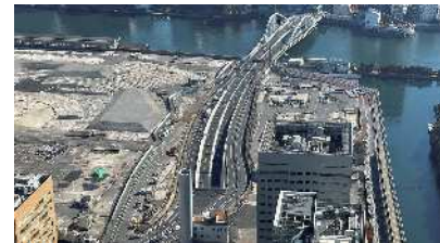
環状第2号線（築地地区）
