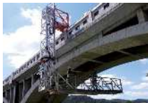
橋梁の点検状況
