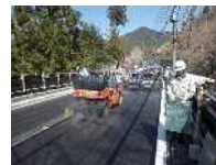
橋面舗装の補修
