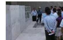
直接見て触れて実感できる研修 （コンクリート擁壁の施工不良モデル）
