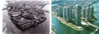
スーパー堤防整備前 (隅田川 大川端地区)
