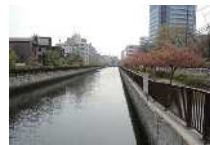
耐震護岸整備 (大横川)
