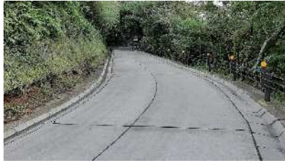
沖港北港線（長浜地区）
