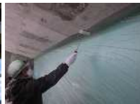
コンクリートの補修状況
