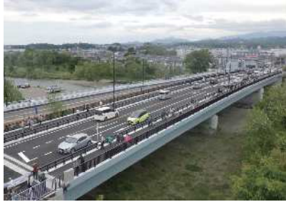
松枝橋【令和2年5月開通】
