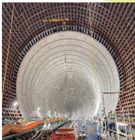
工事中の環状七号線地下広域調節池 (石神井川区間)
