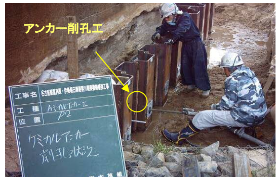
写真-4 フーチングアンカー削孔状況
