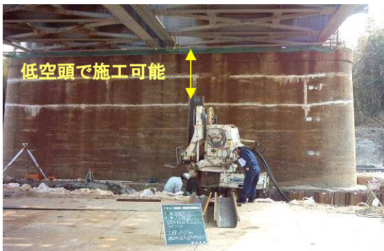
写真-3 シートパイル打設状況
