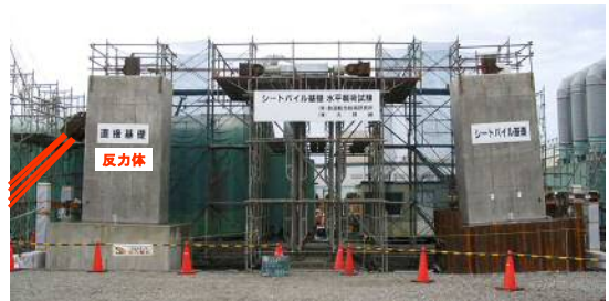
写真-2 シートパイル基礎水平载荷試験 (日経コンストラクション 2004.12.10 号掲載)
