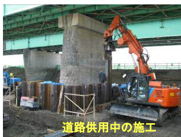
写真-5 シートパイル打設状況
