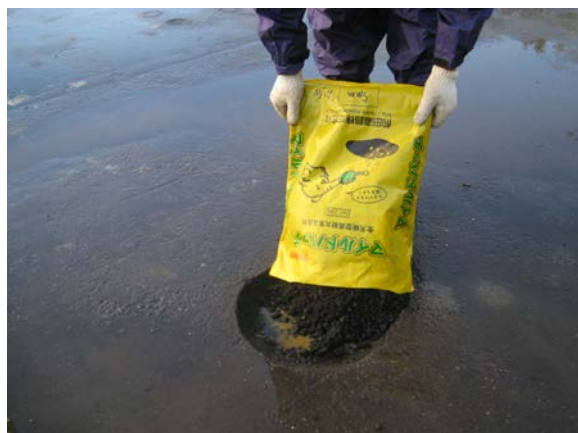
図-1 マイルドパッチ施工状況（雨天時、水溜り発生箇所）
