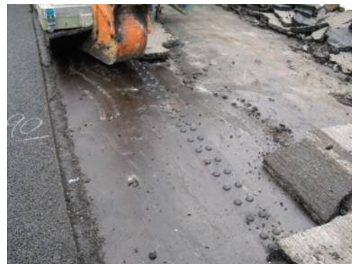
写真-2 撤去後の鋼床版表面
