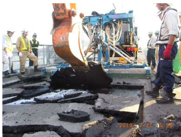
写真-1 IH式加熱機による舗装撤去状況
