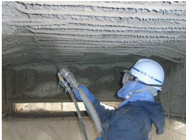
図1 N-SSI工法による吹付け断面修復
