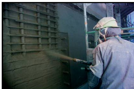
写真-1 乾式吹付耐震補強工法による施工状況
