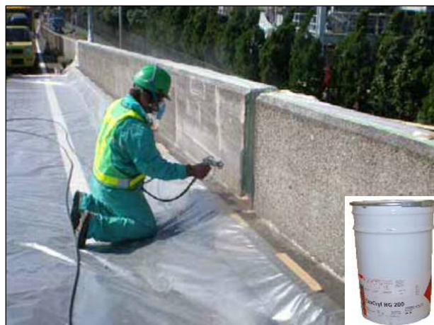
写真-1 表面含浸材 塗布状況
