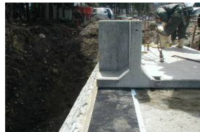
写真3 Gベース基礎背面からの施工状況
