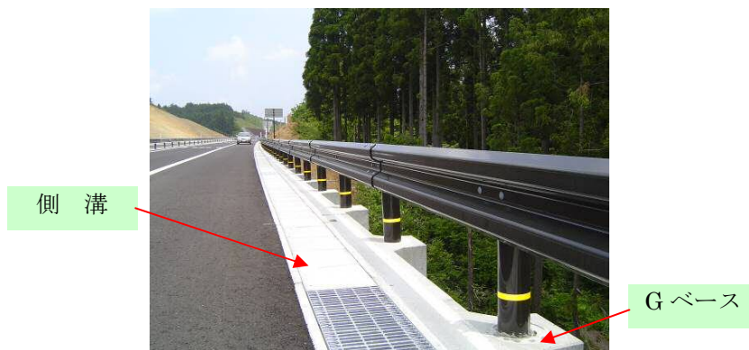
写真1 Gベース施工事例
