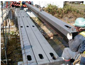
写真2 住宅密集下での施工状況
