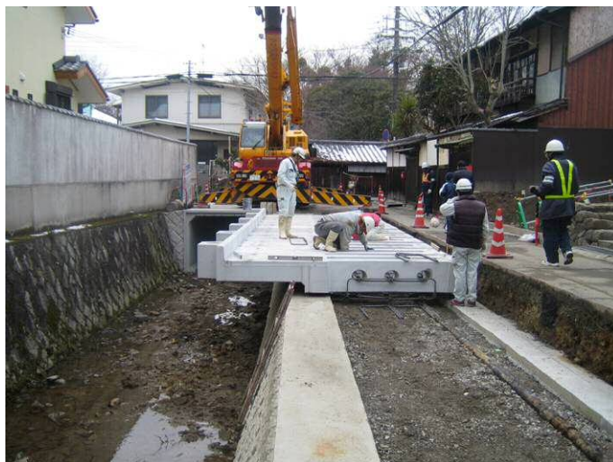
写真1 最大1.75mの車道拡幅が可能
