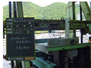
写真3 水平載荷実験
