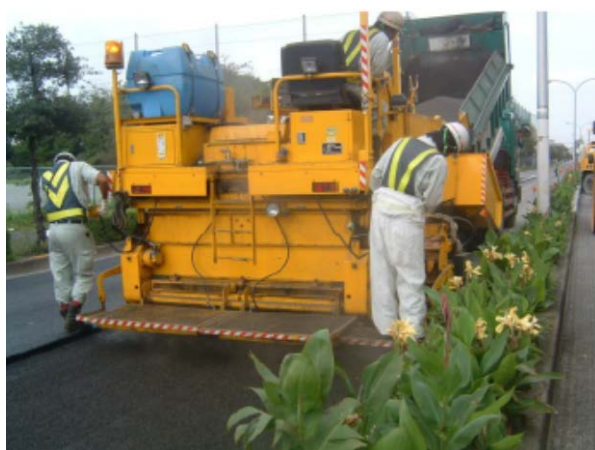
写真-1 エマルテック遮水工法の施工状況
