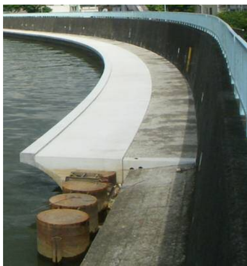
写真-1：中川護岸耐震補強の現況堤防上部工完成状況
