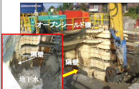
写真2. 切羽掘削状況
