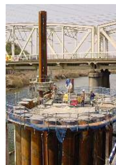
図4 井筒鋼管矢板基礎
