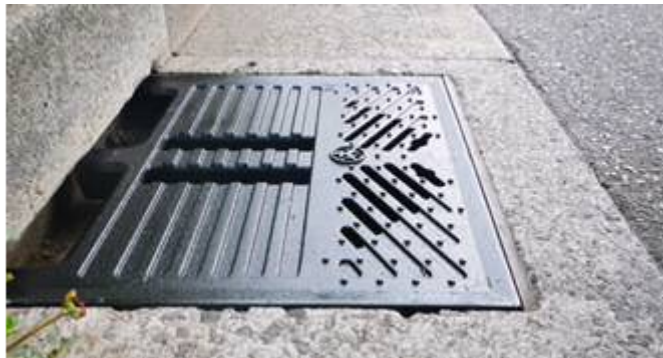
写真-1 60mm/hr の降雨でも越流しない GR-L
