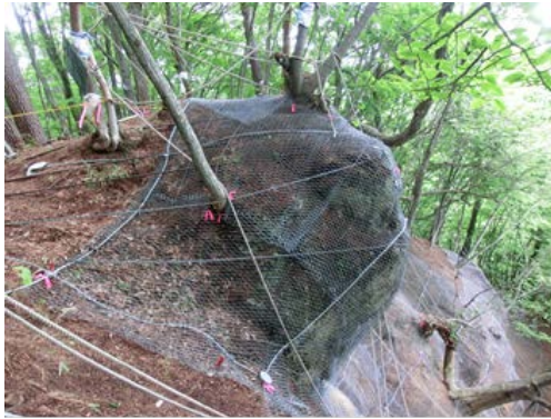
写真-2 金網を併用した場合の完成状態
