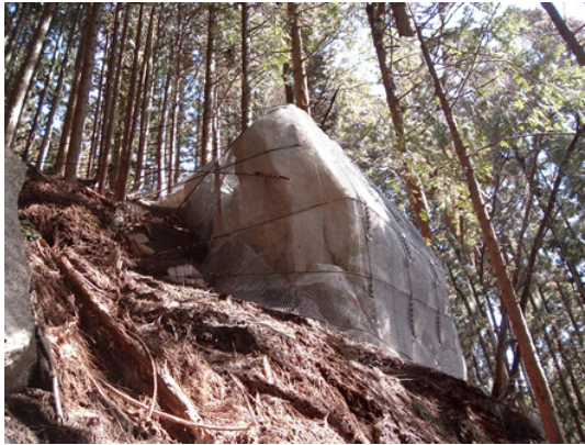
写真-3 金網敷設箇所（愛知県）
