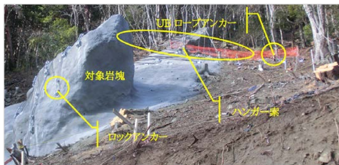
写真-1 巨大岩塊固定工法 施工例
