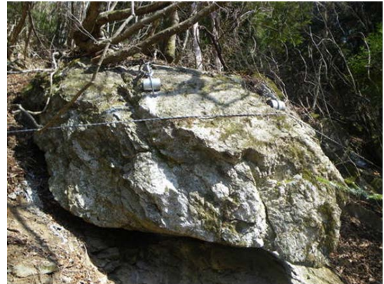
写真-4 ワイヤロープ設置箇所（東京都）
