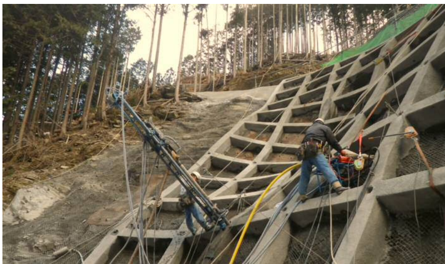
写真-1.ワイヤー緊張方式と軽量削孔機による二重管削孔
