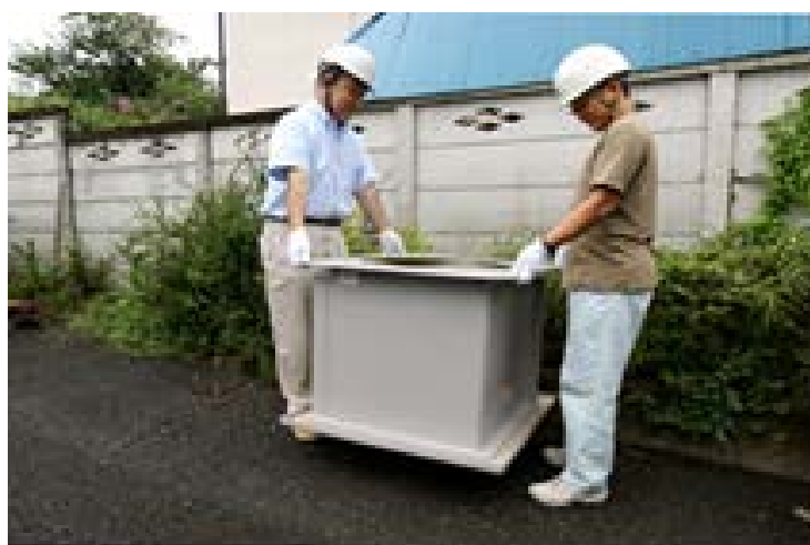
写真-1 人手だけで小運搬できる樹脂製ハンドホール
