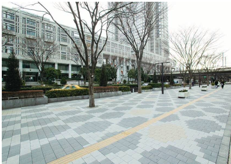
写真-1 都庁周辺施工実績
