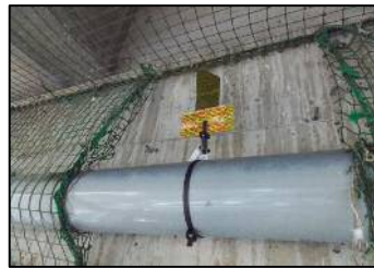
写真-10 施工直後
