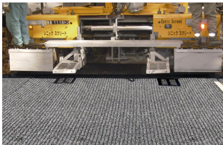
写真-1 専用アスファルトフィニッシャを用いた縦溝粗面形成状況
