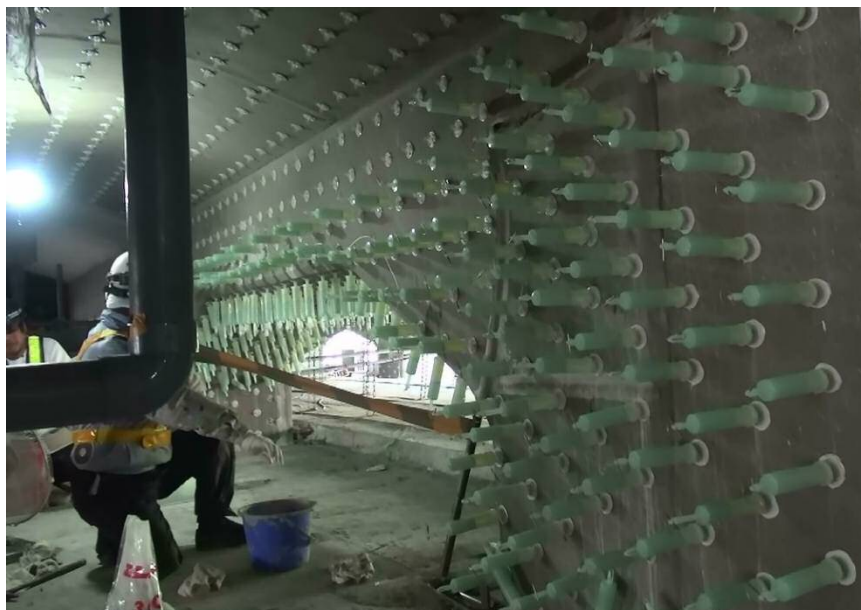
写真-1 施工状況
