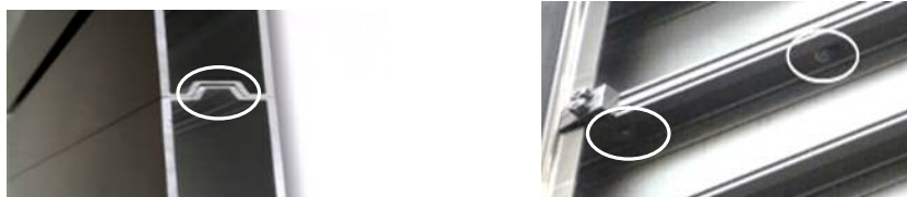
図-4 新技術 (○部凹凸の詰め込み)
