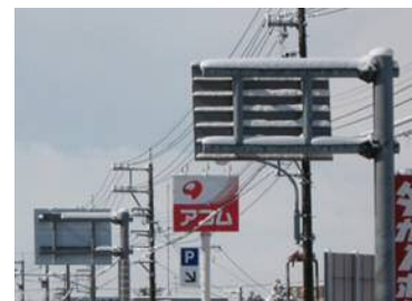
図－１０ 着雪時標識背面 (左：新技術、右：従来品)
