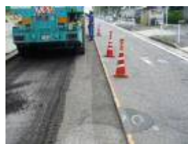
写真-7 アスファルト切削
