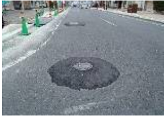
写真-2 従来工法 擦り付け
