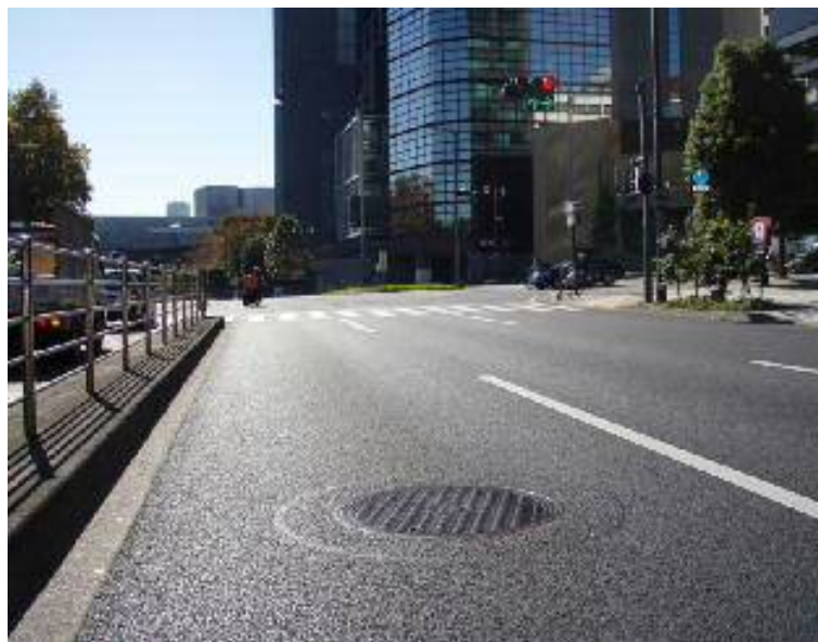
写真-1 セーフティーフラット工法 (P-B工法)
