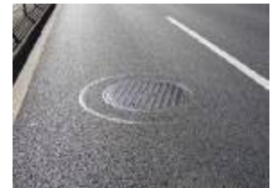
写真-17 排水性完了
