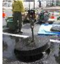
写真-15 仮蓋撤去
