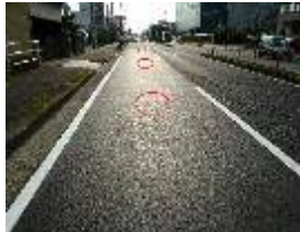
写真-14 舗装完成
