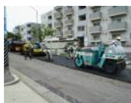
写真-8 アスファルト舗設
