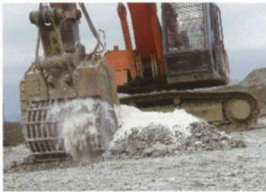
写真-1 デナイトを使用した不溶化処理状況 (粉体/表層)
