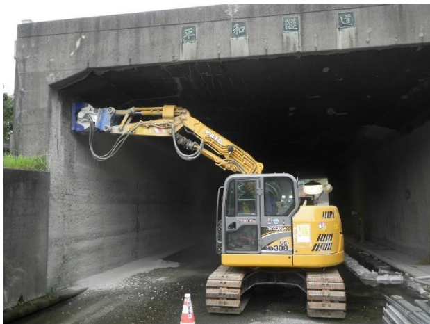
・ 上面切削状況
