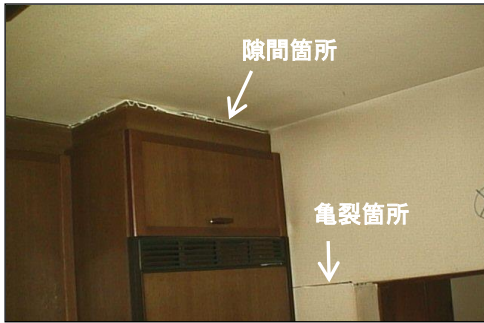
図-2. 実大建物の沈下実験
