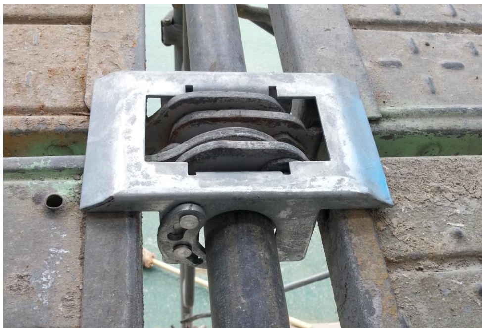
写真-1 エスプレートを布板に設置した状態
