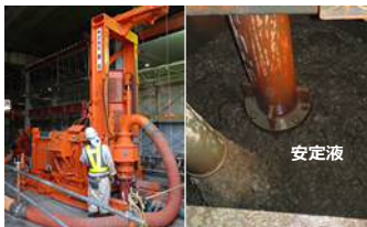
優位性が発揮できる安定液掘削工事
