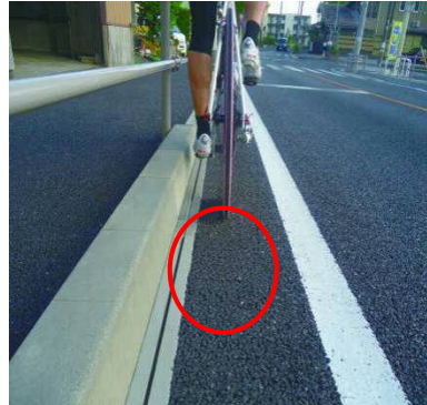
写真-4 段差がなく安全に走行
