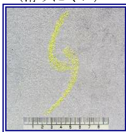
写真-4 自転車に優しい側溝表面
