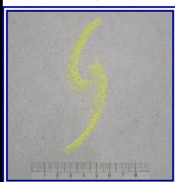
写真-3 一般コンクリート
