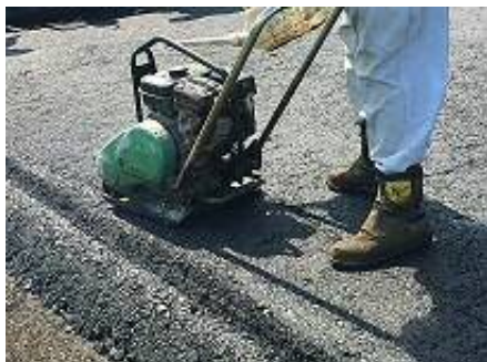
写真-6 舗装機械
