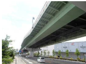
写真-1 高速道路桁
