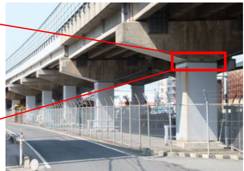
写真-13 鋼板巻き立て全体図
