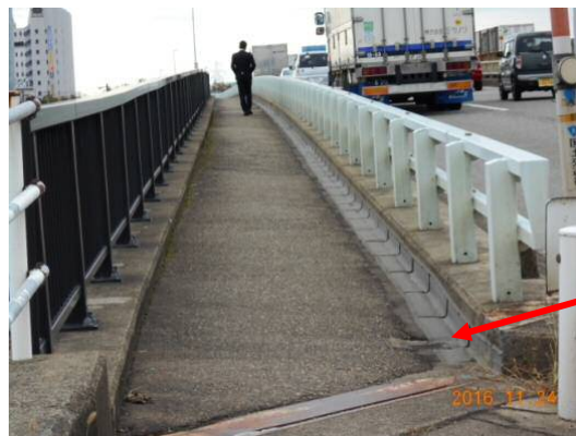
写真-14 橋梁車歩道遊間目地施工例
