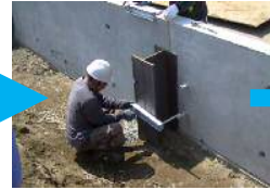
4. 接続金具固定
