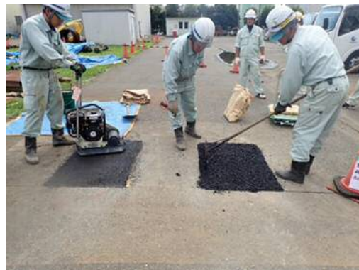
写真-7 施工状況
