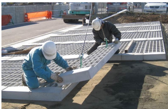
写真-2 コンタイプブロック敷設状況
