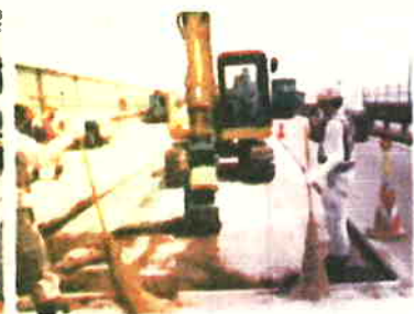
【高架の床盤出し切削】
