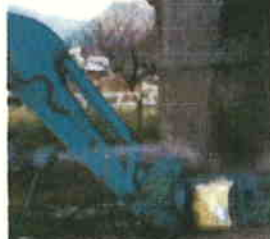
【橋脚の改修時のチップング作業に】
