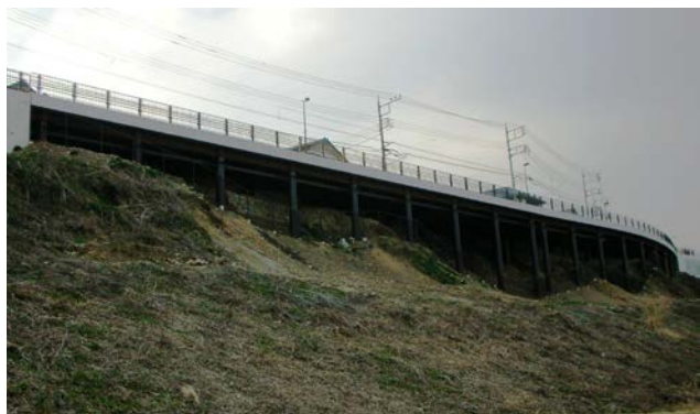
工事実績写真（東京都2013）
