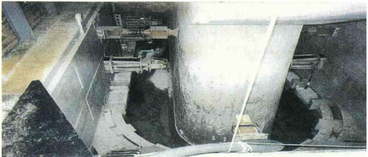
写真 上一色橋耐震補強工事
