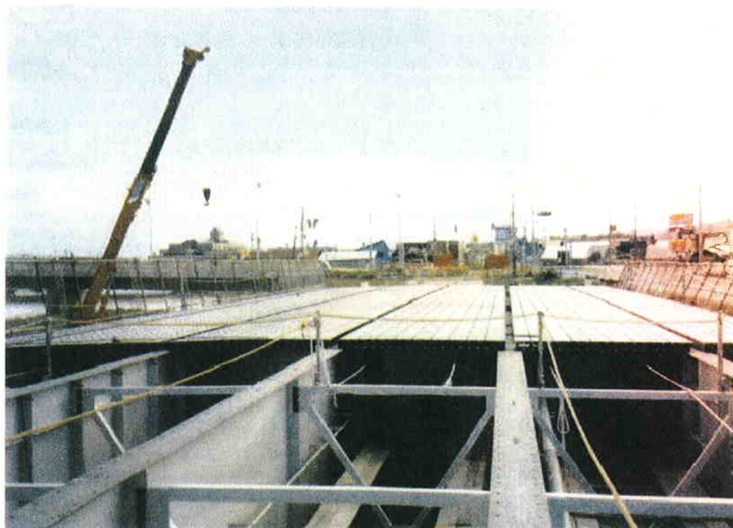
現場状況写真：高流動コンクリートが打設されていない鋼殻だけのウルトラパネルを主桁に順次架設している状況
