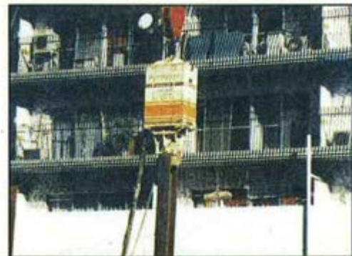
写真三．品川区五反田 マンションから10mの箇所で施工
