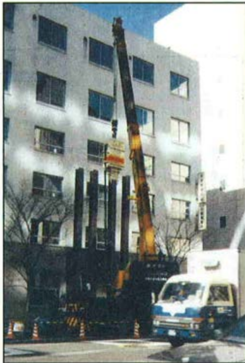
写真一．東京都中央区日本橋浜町 オフィスビルの前の歩道上にて施工。ラフタークレーンによる施工のため機動性が良く、復旧が早かった。
