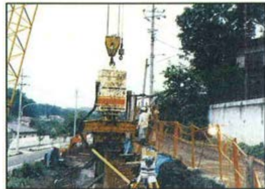
写真二．東京都町田市関師地内 民家の前で鋼管矢板の近接施工
