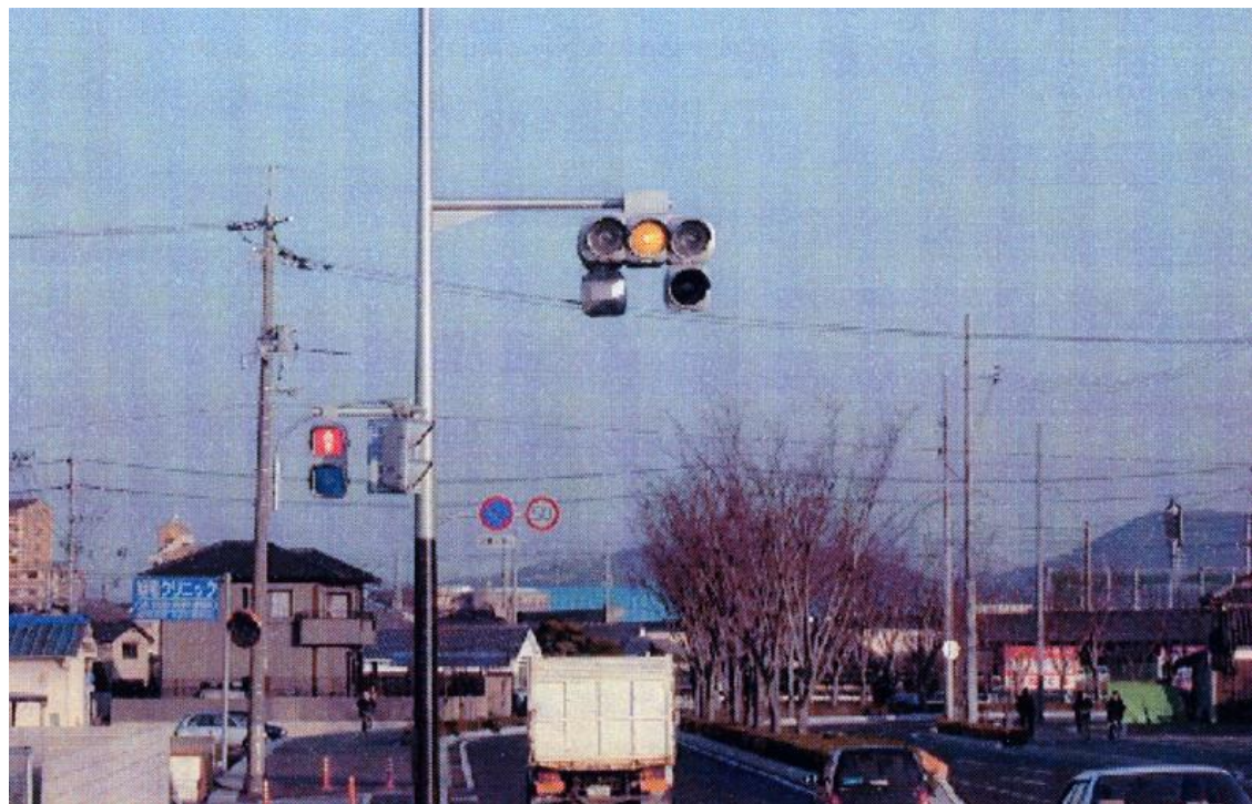
試験設置例（岡山県）
