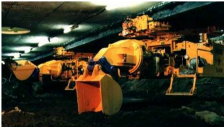
DREAM II 普通土掘削状況
