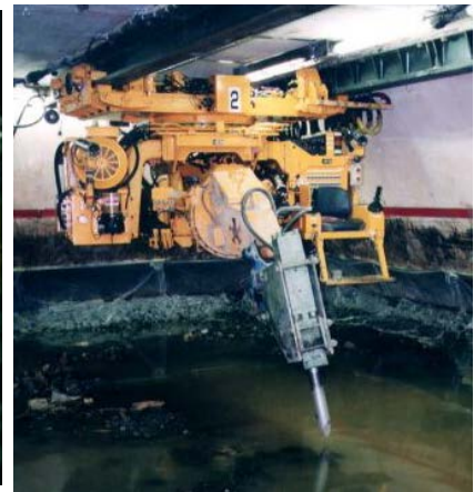
DREAM II 硬岩掘削状況
