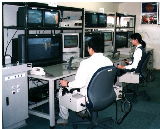
地上からの DREAM II 遠隔操作状況
