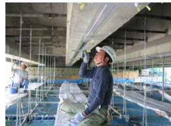
⑦プレート緊張材仕上げ塗装
