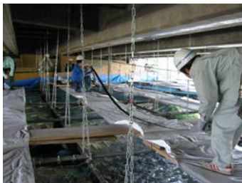
⑤プレート緊張材搬入
