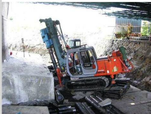
低空頭施工状況
