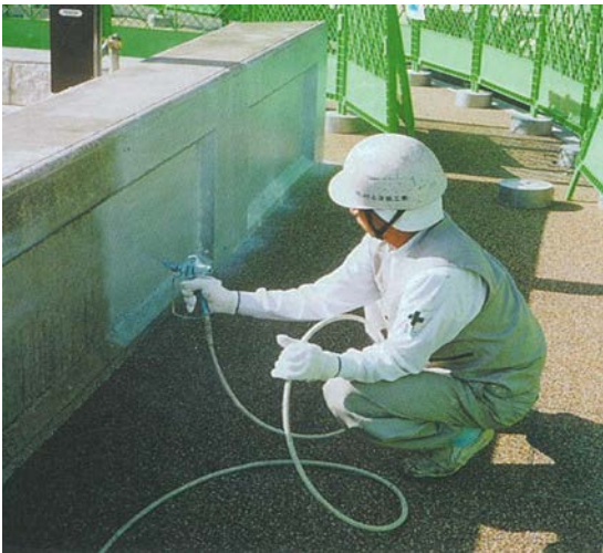
ダム堤体高欄
