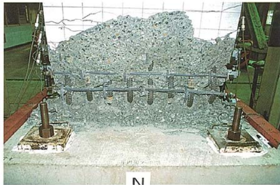
半円形フックの場合 106y時の損害状況 (8y:主鉄筋降伏時の変位) 定着がゆるみ、拘束効果が低下し、主鉄筋が座屈し部材耐力の低下が大きい。
