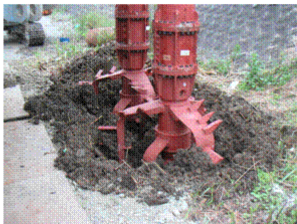
写真-5 \phi 1,600\text{mm} \times 2 軸 施工状況
