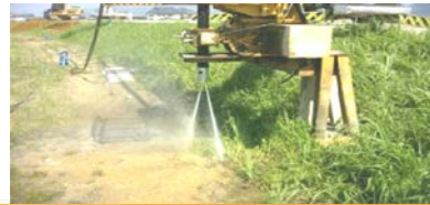
障害物削孔時の噴射状況
